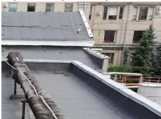
Уклон парапеной крышки не обеспечивает отток воды в сторону кровли.
