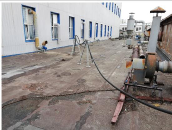
Участки кровли со старым гидроизоляционным покрытием.
